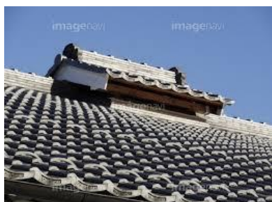
和風住宅屋根裏の換気口
