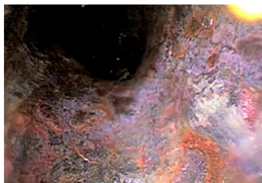
給水管の内視鏡調査
